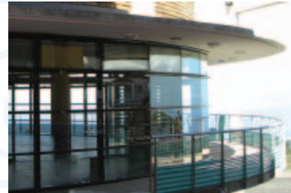
Restaurant : confort visuel, éclairage naturel et vue sur l'extérieur
