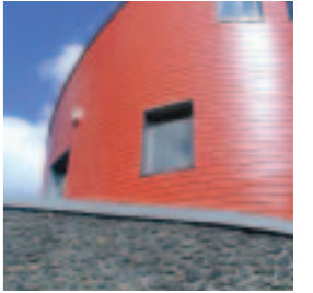
réutilisation intégrale des déblais rocheux
